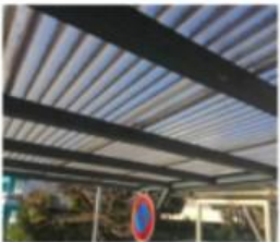
M005 - structure metal et tole Absence d'amiante
