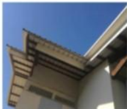
M003 - CHARPENTE BOIS ET TOLE Absence d'amiante
