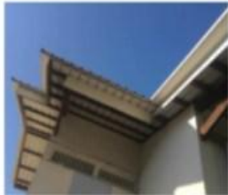
M003 - CHARPENTE BOIS ET TOLE Absence d'amiante
